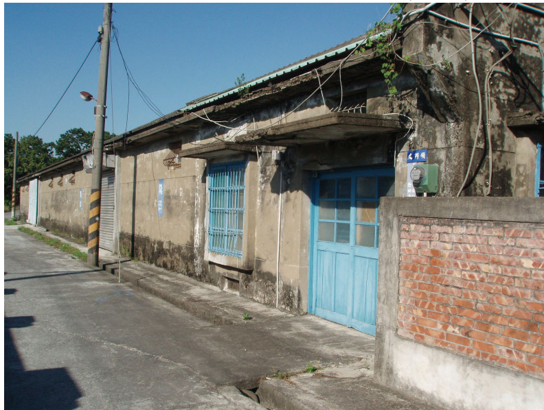
圖 4 嘉南農田水利會隆田倉庫 3、4 號倉庫(基地 A)
