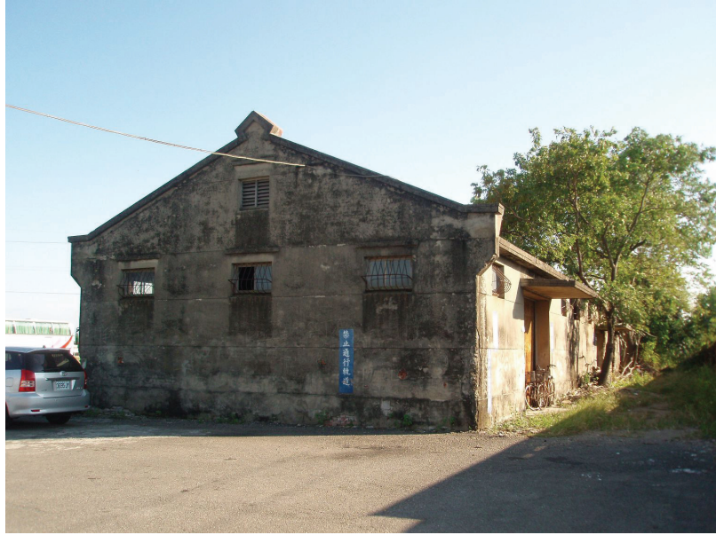
圖 3 嘉南農田水利會隆田倉庫 2 號倉庫(基地 A)
